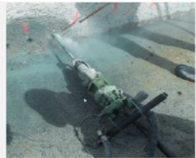
Perçage + lance à eau
