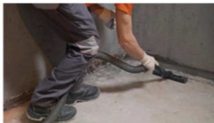
Nettoyage de chantier
