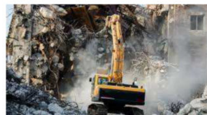
Démolition Avec engins
