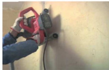
Électricité Saignée, rainurage dans mur en béton
