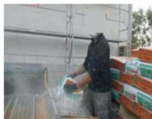
Ravaleur, maçon Grattage d'enduit, malaxage...
