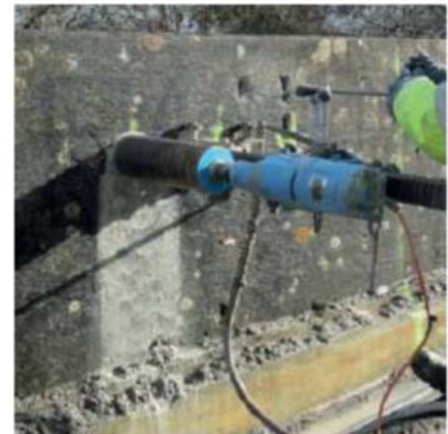
Carotteuse avec abattage à l'humide
